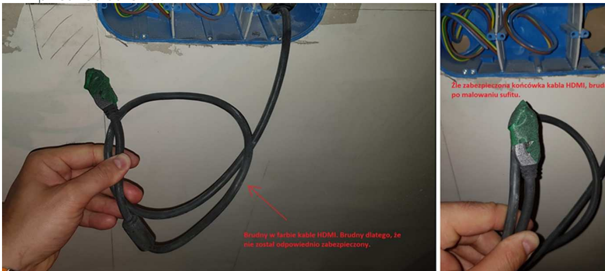
e) Zabezpieczenie kabli HDMI przed zabrudzeniem
